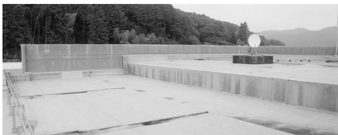
太陽光パネル設置が検討される庁舎屋上
