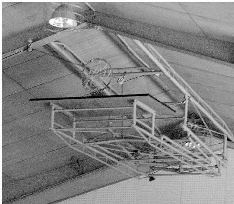
耐震点検が求められるバスケットゴール板
