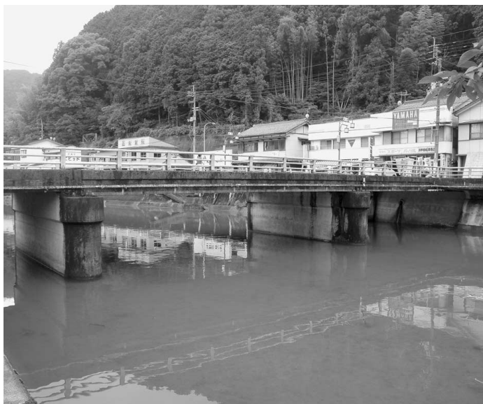
早急な耐震診断が待たれる役場前の佐川橋
