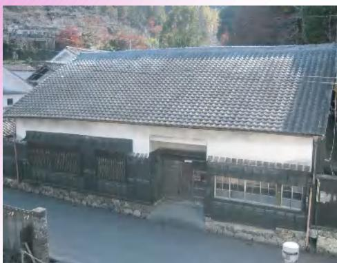
歴史的風致形成建造物指定予定の浜口邸の内外装の整備、耐震補強を実施。旅の宿としての機能を付加する。
