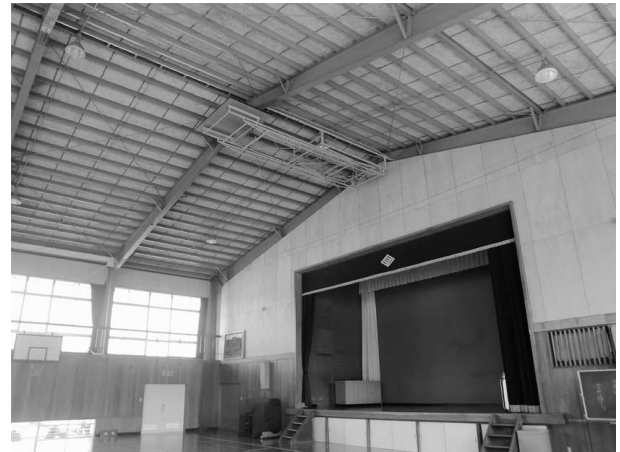
防災拠点としての点検・整備が急がれる
