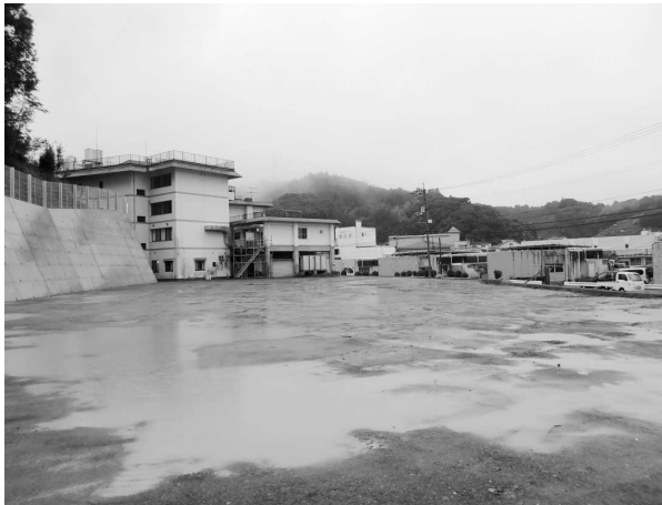
造成工事が完了した高北病院建設地
