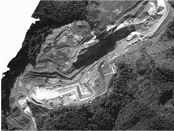
新産廃建設 工法・予算の大きな見直し
