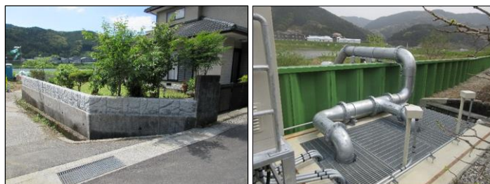
浸水防止壁と雨水排水ポンプ（馬越地区）
