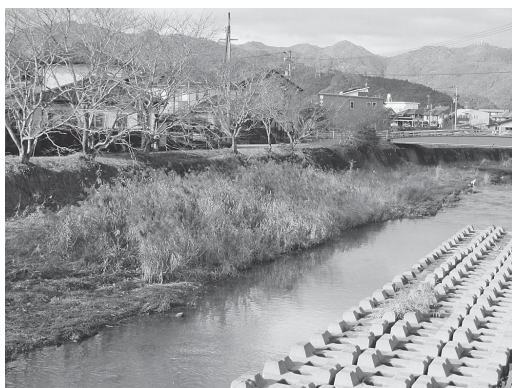
土砂が堆積し、氾濫が心配される河川
