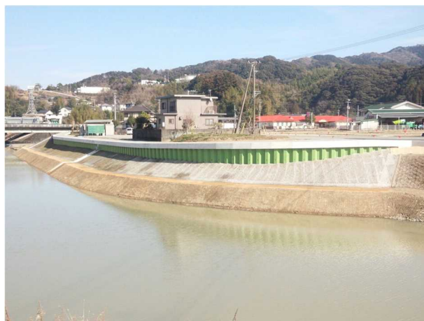
写真1-5 日下川河川改修状況
