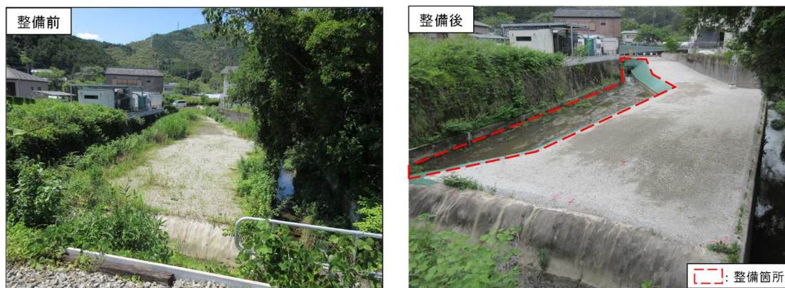
写真4-3 日高村が行う水路の整備（岡花地区）
