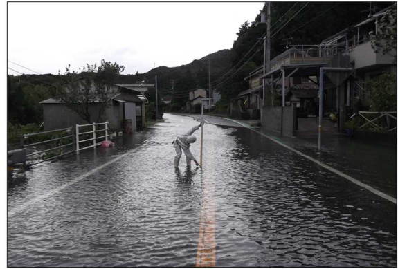
【岡花地区の国道33号冠水状況】
