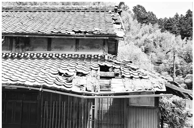
倒壊や落下の危険性のある屋根瓦
