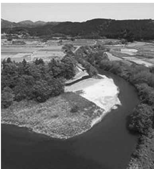
未改修のままの柳瀬川
