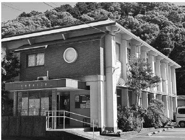
老朽化の進む商工会館
