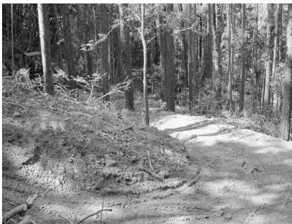
急カーブの多い作業道
