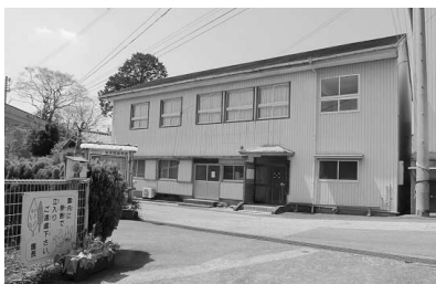
加茂地区住民センター
