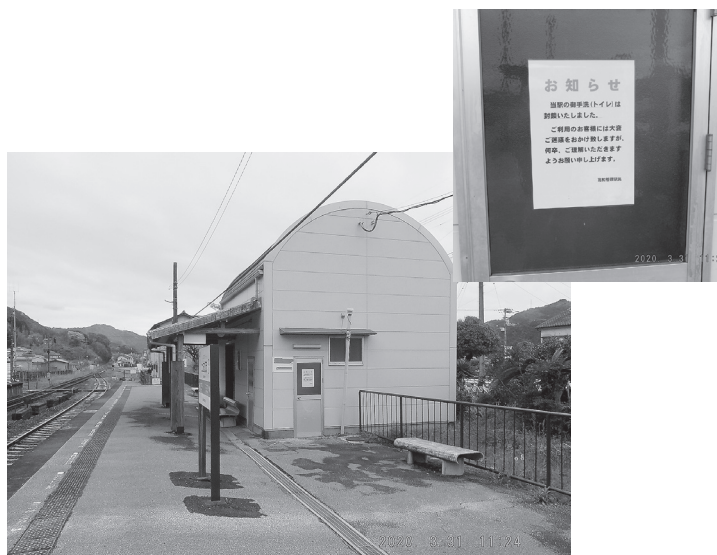
加茂駅舎のトイレが使えない！
