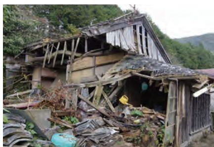
老朽住宅除去前
