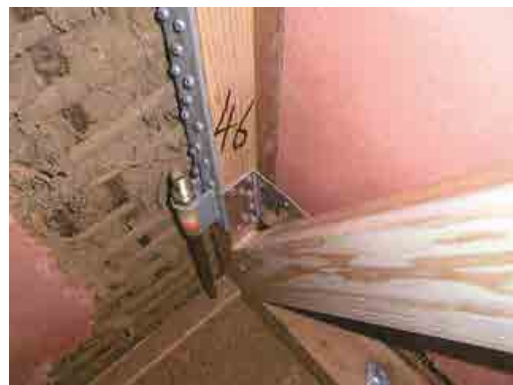
耐震化工事後の強化部の様子
