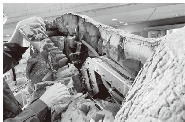
写真：メンテナンスの様子。皮を切って中の機械の交換をしていきます。
